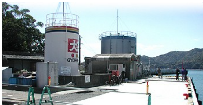
改修工事が完了した給油施設の全景
